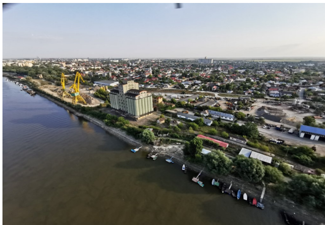
Portul și silozul Foto: Florin Rădulescu
